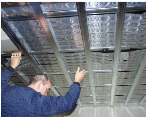
Abb. 1: Einbau makroverkapselter Salzhydrate in abgehängte Deckenkonstruktion
